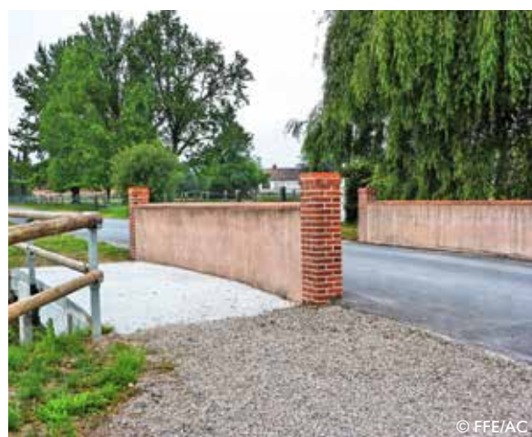
Chemin longeant la route : passage sécurisé pour les chevaux au niveau d'un pont.
